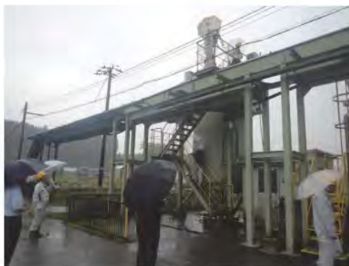
赤目坑水中和槽
