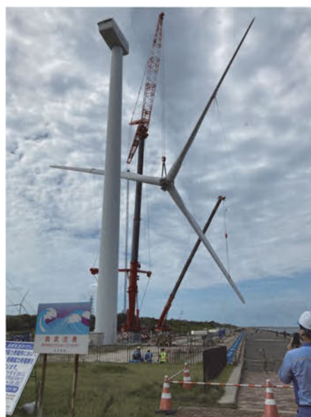
写真8 響灘陸上風力発電機の解体工事
