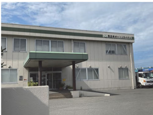
写真 5 西日本オートリサイクル(株)（外観）
