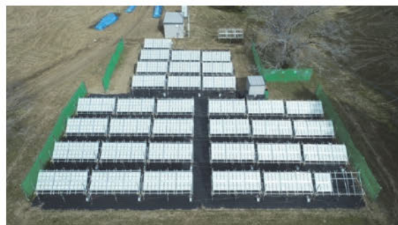
図 6 \text{RhCrO}_x/\text{SrTiO}_3:\text{Al} 光触媒を用いた 100 \text{m}^2 規模でのソーラー水分解による水素製造の実証試験。粉末光触媒を塗布したパネルが複数並べられている。ガス分離システムも備えている。
