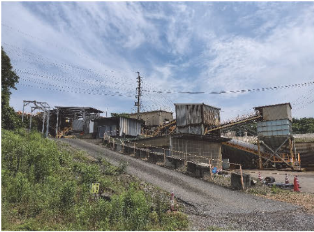
春日鉱山破碎設備
