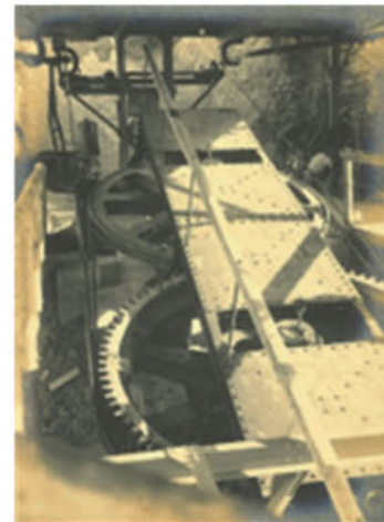
図5 搬器荷卸配分装置の一部
