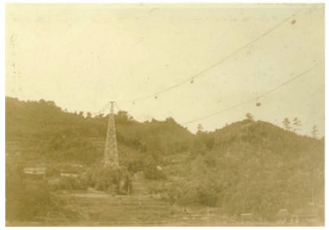
図4 架空索道の稼働状況②
