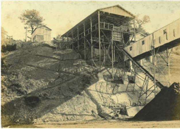
図2 架空索道の停留場とトランスポーター（ベルトコンベアー）との接続地点
